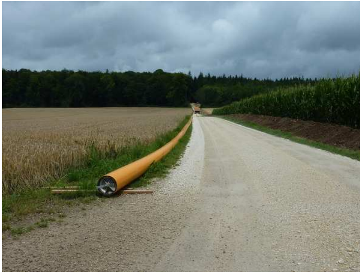
Zwischen Korn und Mais führt die Gasleitung von Kirchen auf die Ehinger Alb. Und mit dem Gas kommt Glasfaser nach Dächingen und Frankenhofen. Fotograf: ah
