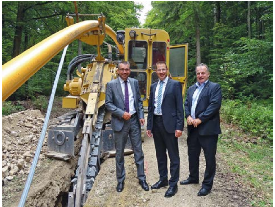
Backboneverlegung im Rahmen einer Mitverlegungsmaßnahme (Gasleitung) bei Ehingen-Dächingen. V.l.n.r. Oberbürgermeister Alexander Baumann (Ehingen), Landrat Heiner Scheffold und Ministerialdirektor Stefan Krebs, Beauftragter der Landesregierung für Informationstechnologie
